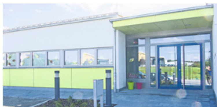
2014 fertiggestellt: Die neue Kita auf der Spilburg
